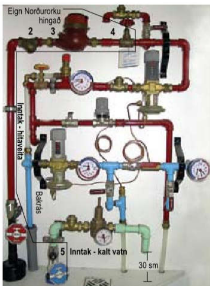
MYND 4 Inntaksgrind í íbúðarhús, t.v. og inntaksskápur á sumarhúsi t.h. (úr bæklingi Norðurorku, Heimagnir).
